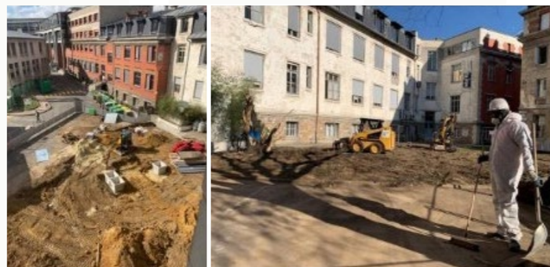
Création de la future zone dédiée à la soute provisoire
